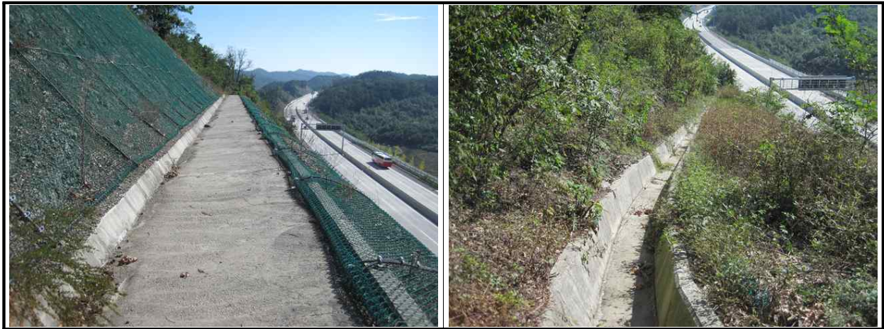
【그림 50.3.3】 배수시설 전경
