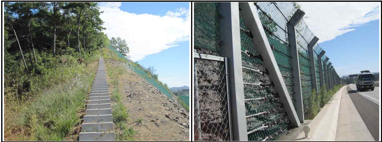
【그림 50.3.4】 보호/보강시설 전경
